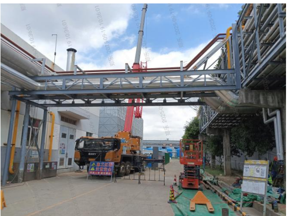
项目拟建址西侧
