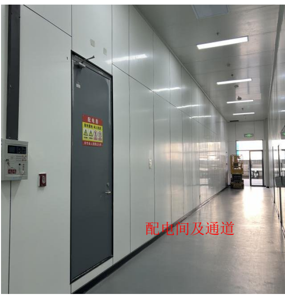
图 8-4 拟建址西侧（配电间及通道）
