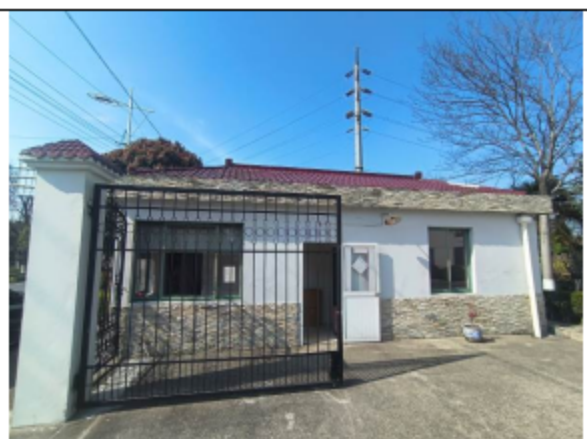
图1-4 太仓迪泰科仪器有限公司门卫室
