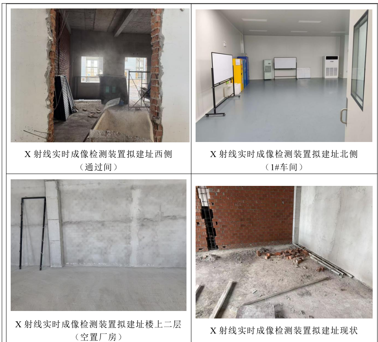
图 8-1 X 射线实时成像检测装置拟建址周围环境现状照片
