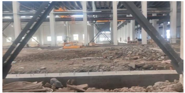
探伤铅房拟建址西侧
