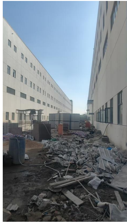
探伤铅房拟建址东侧
